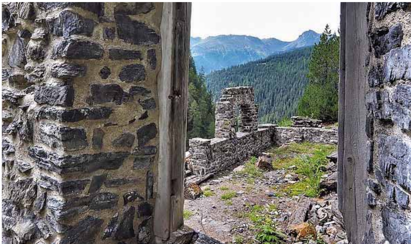
Blick in die Ruinen des Poch- und Waschwerkes
