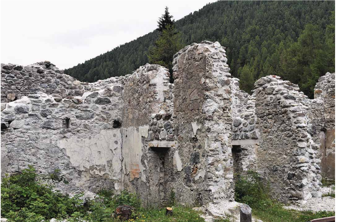
Ruine der Schmelzhütte in S-charl
