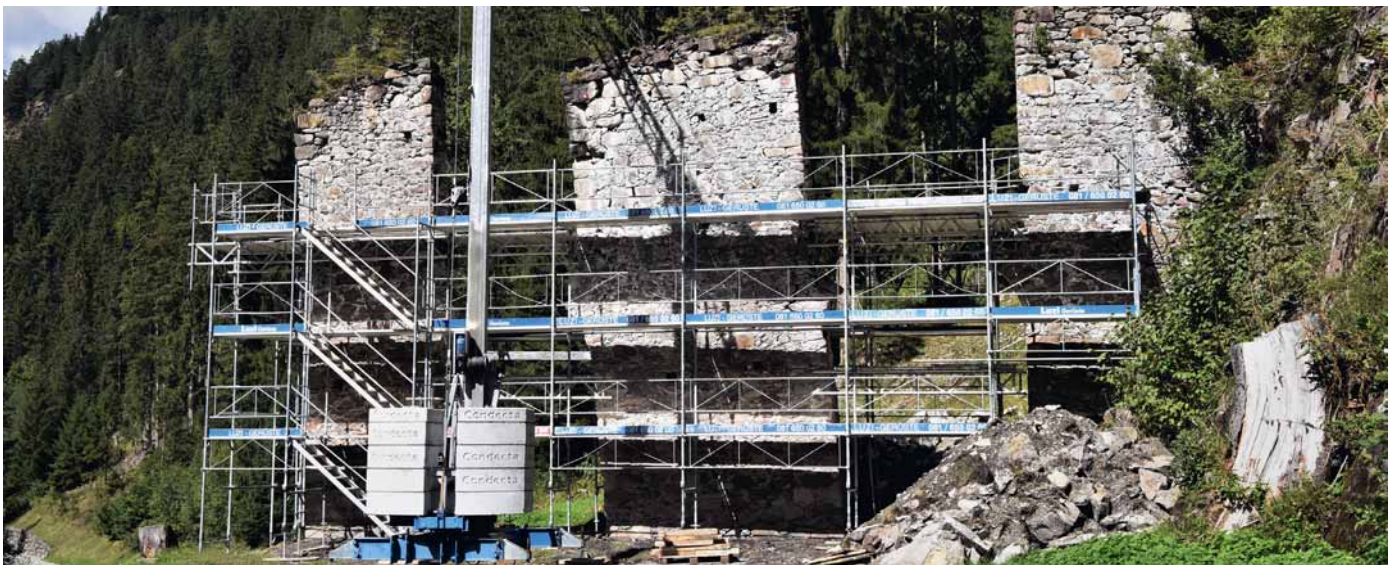
Die Sanierung hat begonnen.
