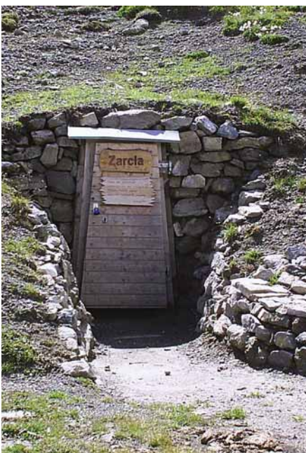
Der mit einem Vorbau gesicherte Stollen «Zarcla». (Bild Amis)
