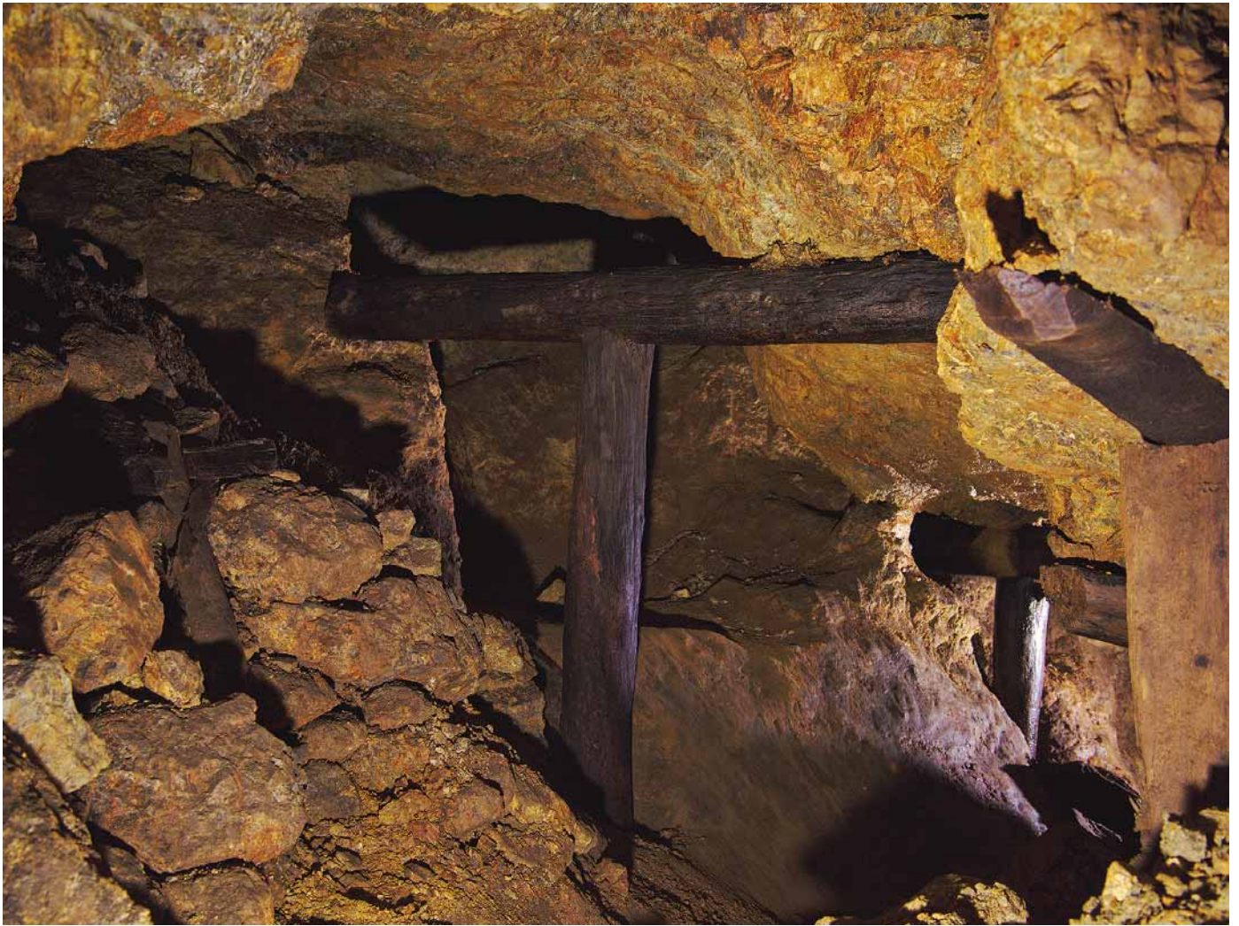
Zimmerung im Stollen S. Michael
